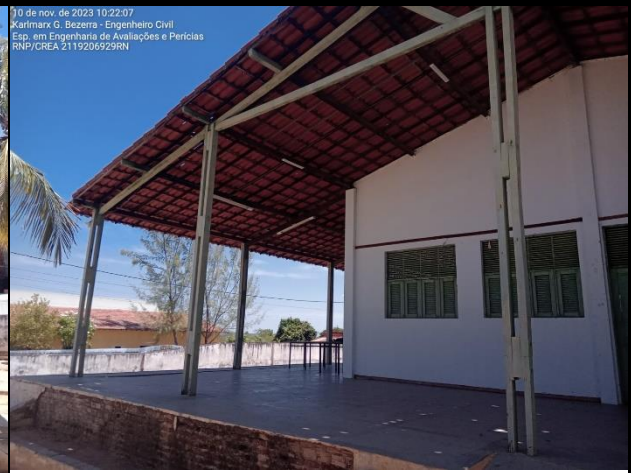
Foto 02: VISTA DA FACHADA DO CCI
