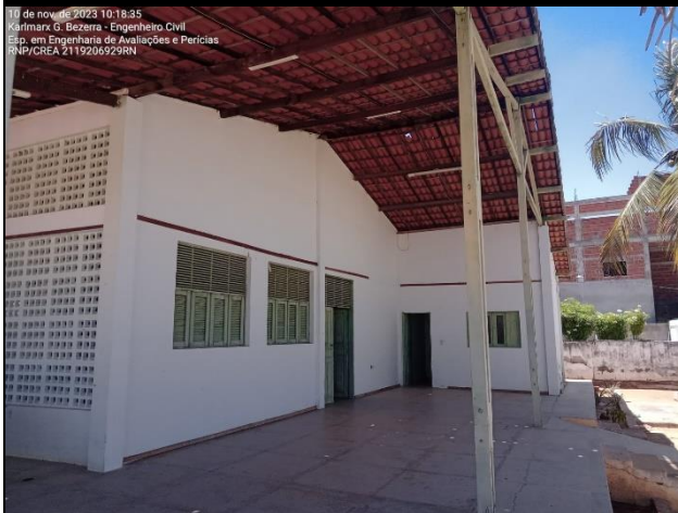
Foto 01: VISTA DA FACHADA DO CCI
