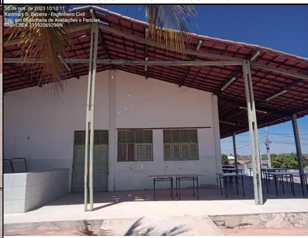
Foto 10: PILARES COM FLAMBAGEM
