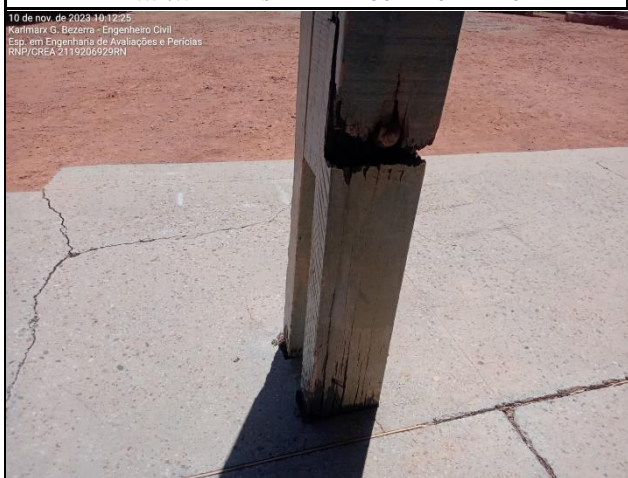
Foto 09: PILAR COMPROMETIDO
