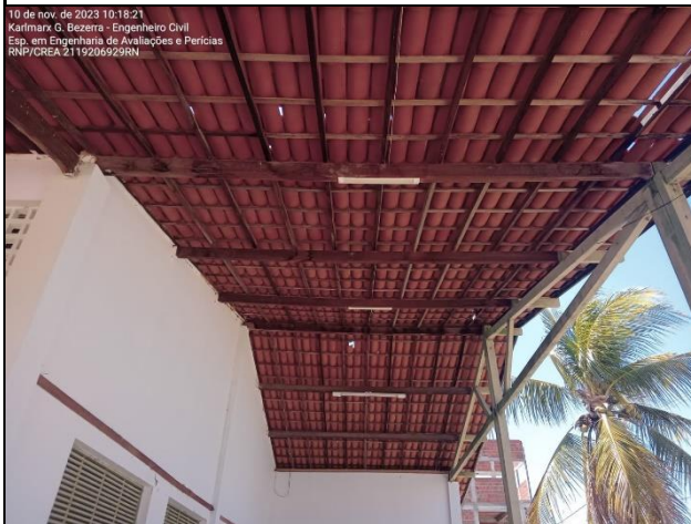
Foto 03: TRAMA COMPROMETIDA, TERÇAS COM FLEXA.
