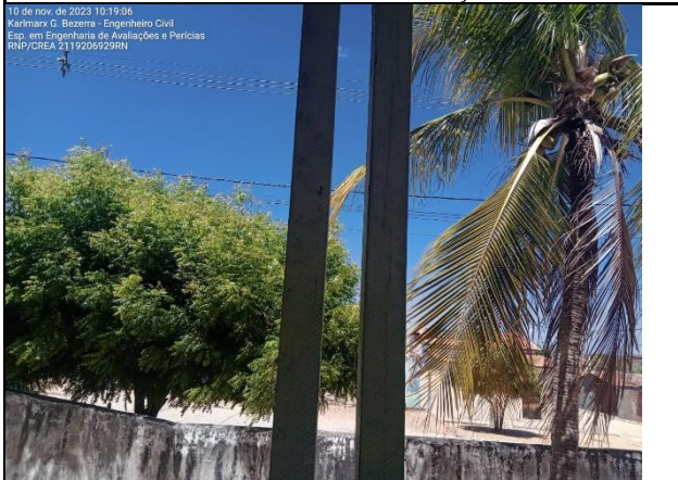
Foto 05: FISSURAS E FLAMBAGEM NOS PILARES FRONTAL
