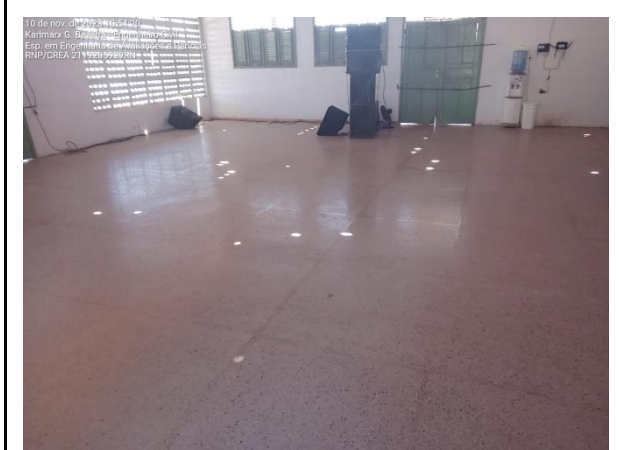
Foto 42: PISO DO SALÃO EM BOAS CONDIÇÕES NECESSITA DE POLIMENTO
