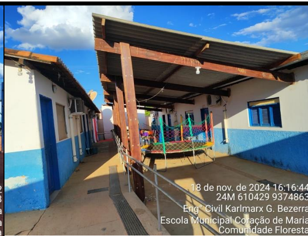
Foto 02: Cobertura existente. Visualiza-se que o corredor não está coberto totalmente, o que deverá ser adequado.
