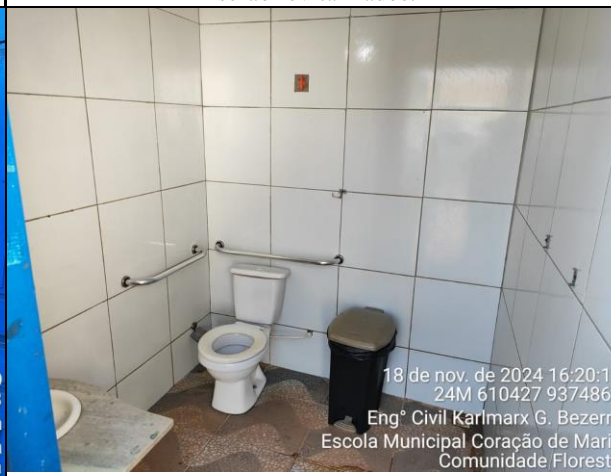
Foto 12: Banheiros terão portas e pisos substituídos e serão revitalizados.1
