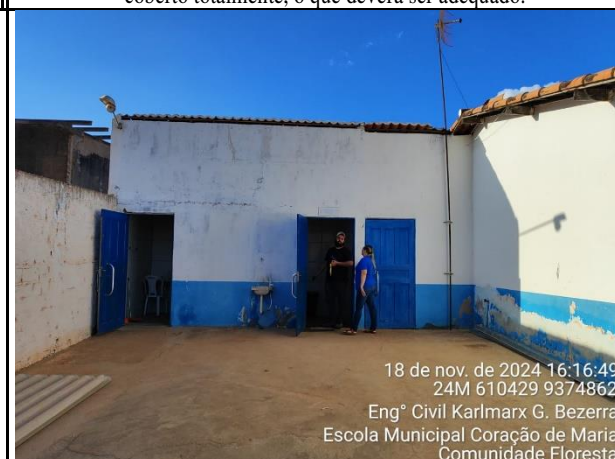
Foto 04: Vista do pátio que será coberto..
