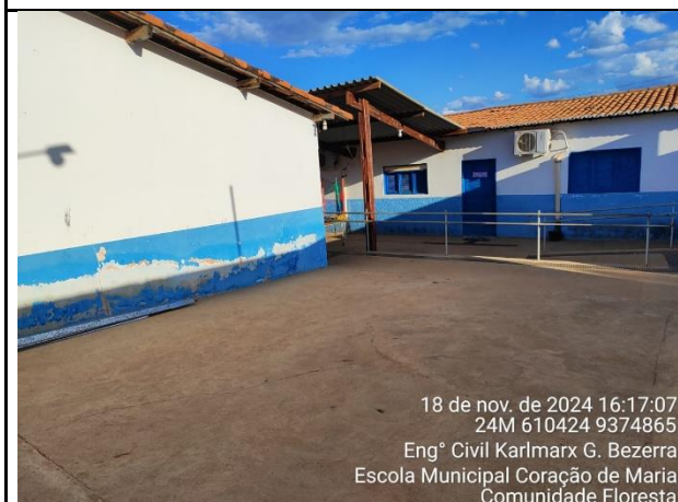
Foto 03: Vista do pátio que será coberto.
