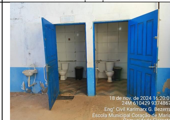
Foto 06: Banheiros terão portas e pisos substituídos e serão revitalizados.
