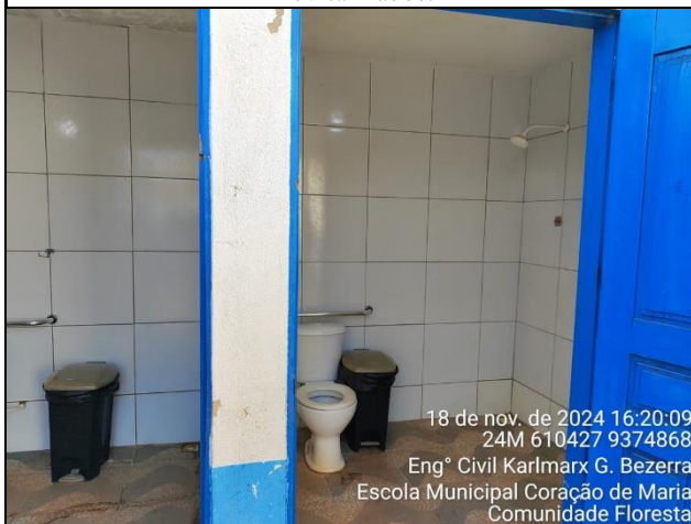
Foto 11: Banheiros terão portas e pisos substituídos e serão revitalizados.1
