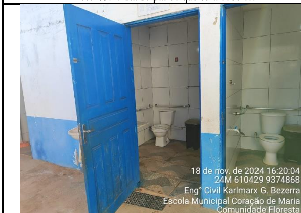
Foto 05: Banheiros terão portas e pisos substituídos e serão revitalizados.
