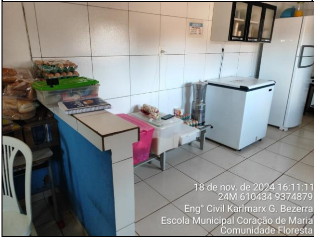
Foto 15: Será executado uma bancada ao lado da parede americana.
