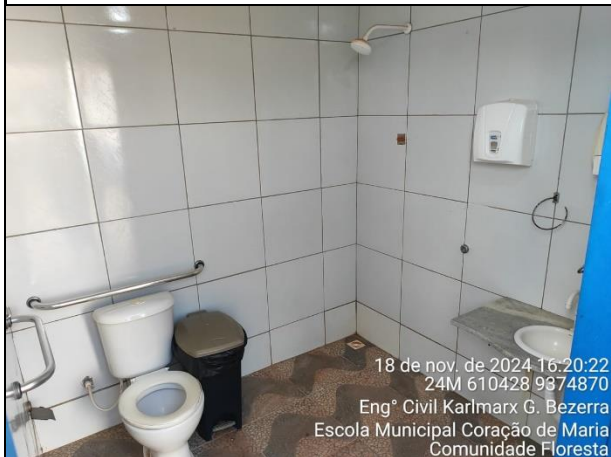
Foto 09: Banheiros terão portas e pisos substituídos e serão revitalizados.
