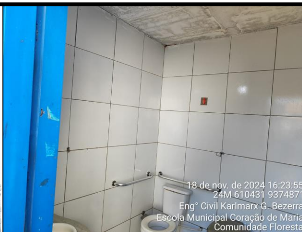
Foto 08: Banheiros terão portas e pisos substituídos e serão revitalizados.
