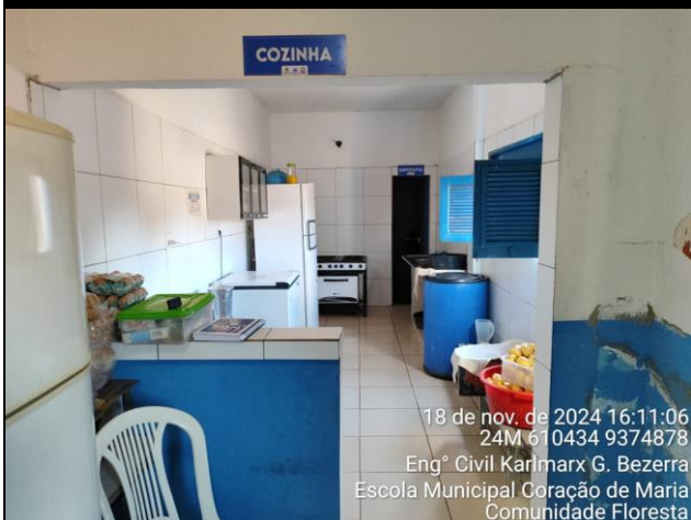
Foto 13: Vista da cozinha, receberá duas bancadas.
