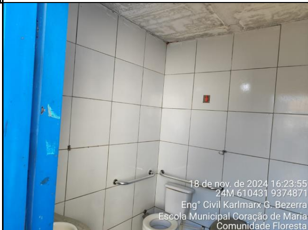
Foto 10: Banheiros terão portas e pisos substituídos e serão revitalizados.
