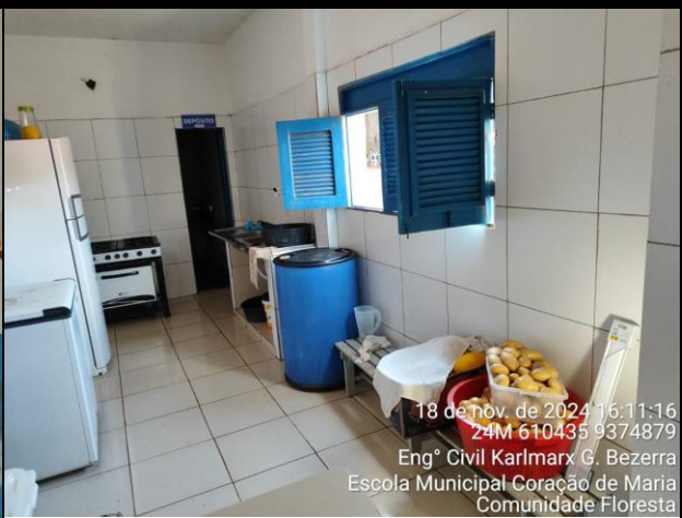
Foto 14: Será executada uma bancada ao lado da pia.
